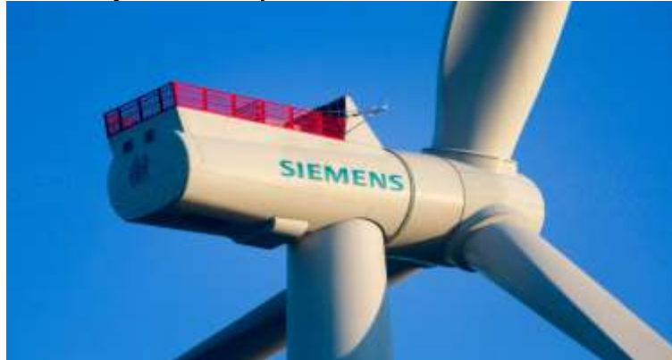
Fig. 6 Siemens SWT-7.0-154 WTG
